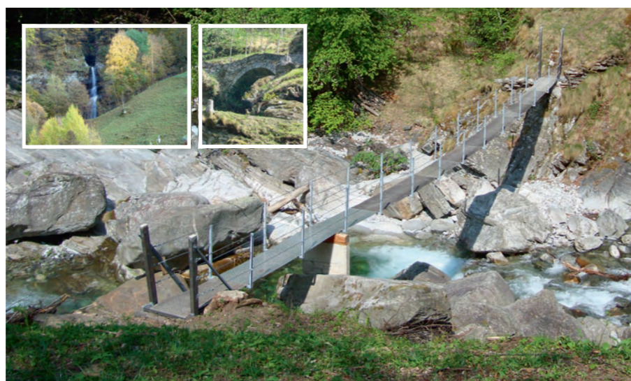
Avant les travaux | Le pont romain | La nouvelle passerelle
